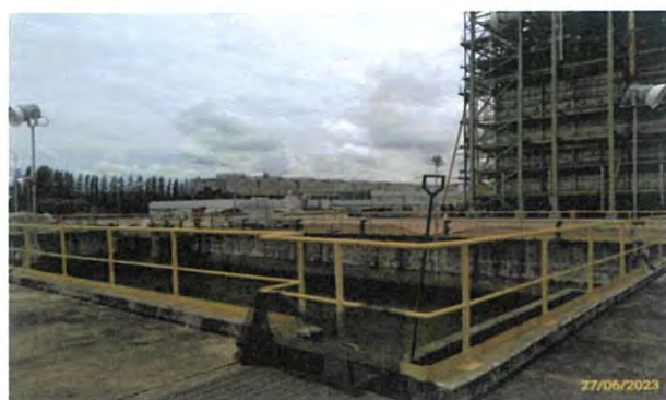
Storm Water Diversion Box 4 ขนาด 615 m3 เพื่อรองรับน้ำฝนปนเปื้อนบริเวณพื้นที่กระบวนการผลิต (เตาแตกตัวโมเลกุล)
