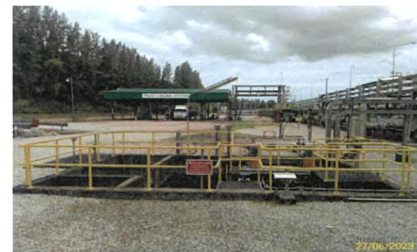
Storm Water Diversion Box 3 ขนาด 40 m3 เพื่อรองรับน้ำฝนปนเปื้อนบริเวณพื้นที่สถานีขนส่ง ทางรถบรรทุก
