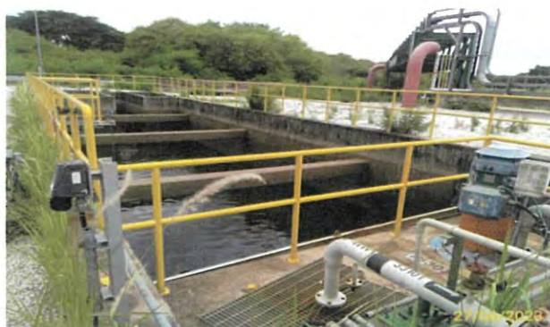
Storm Water Diversion Box 1 ขนาด 400 m3 เพื่อรองรับน้ำฝนปนเปื้อนบริเวณพื้นที่ลานดัง
