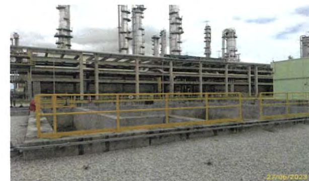
Storm Water Diversion Box 6 ขนาด 800 m3 เพื่อรองรับน้ำฝนปนเปื้อนบริเวณพื้นที่หน่วยผลิตโอ เลฟินส์ส่วนเสริม
