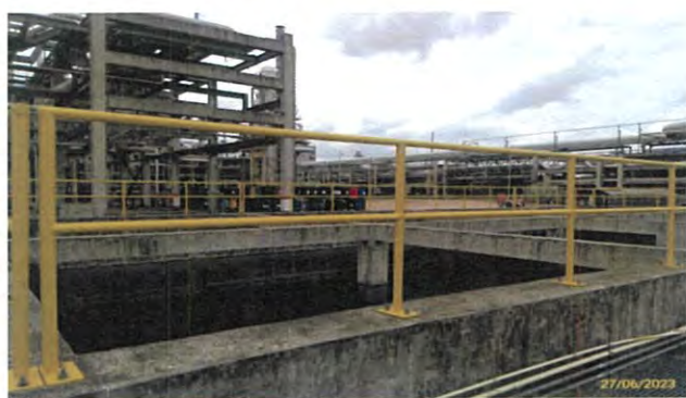
Storm Water Diversion Box 5 ขนาด 500 m3 เพื่อรองรับน้ำฝนปนเปื้อนบริเวณหน่วยผลิตสารประกอบคาร์บอน 4 อะตอม และหน่วยผลิตสารประกอบคาร์บอน 5 อะตอม
